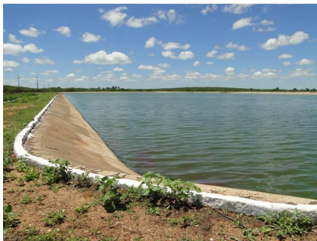
ETE Pendências, Pendências/RN
